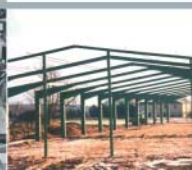
1994/95 Bau der neuen Halle des Möbelwerks
